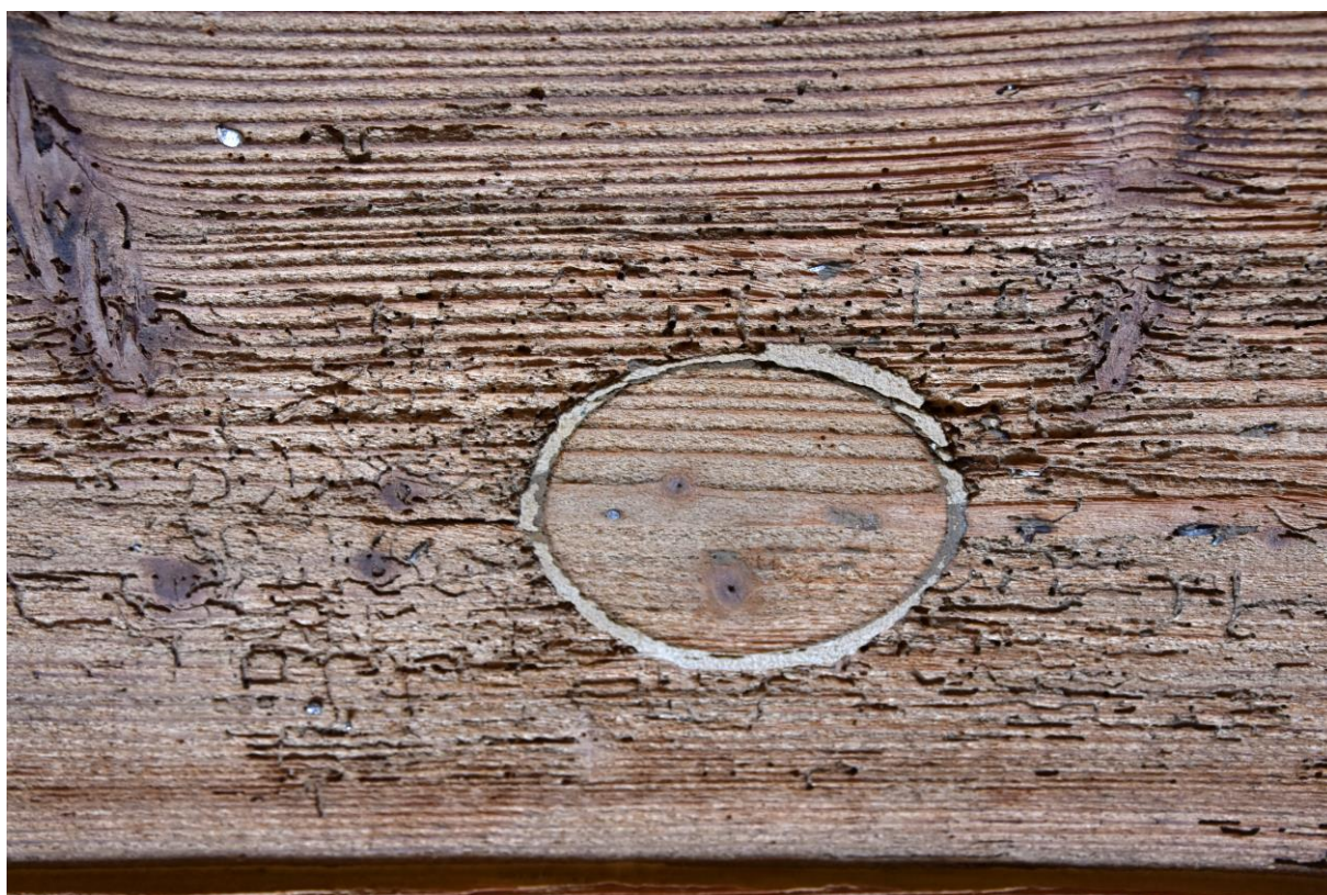
Dveře severní balkon, detail druhotně vyplněného otvoru v ploše dveří, vnitřní plocha.
