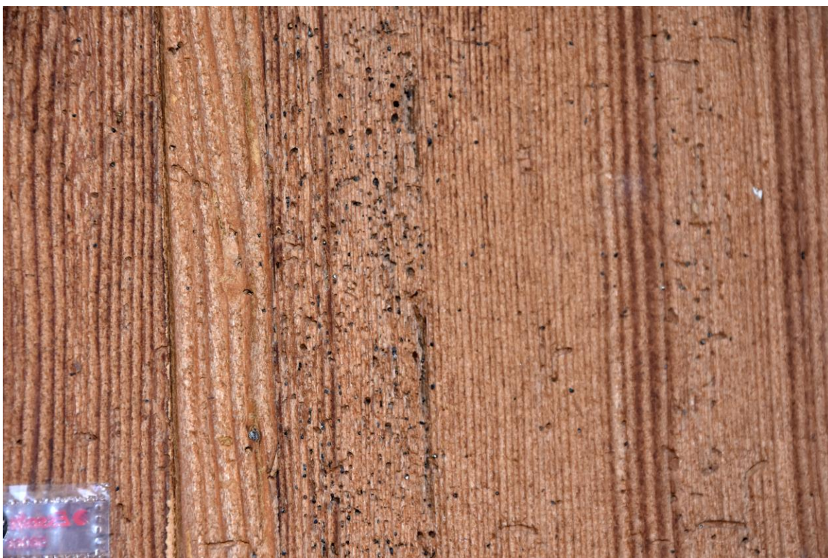
Dveře na kůr severní, detail stavu dřevní hmoty, vnitřní plocha
