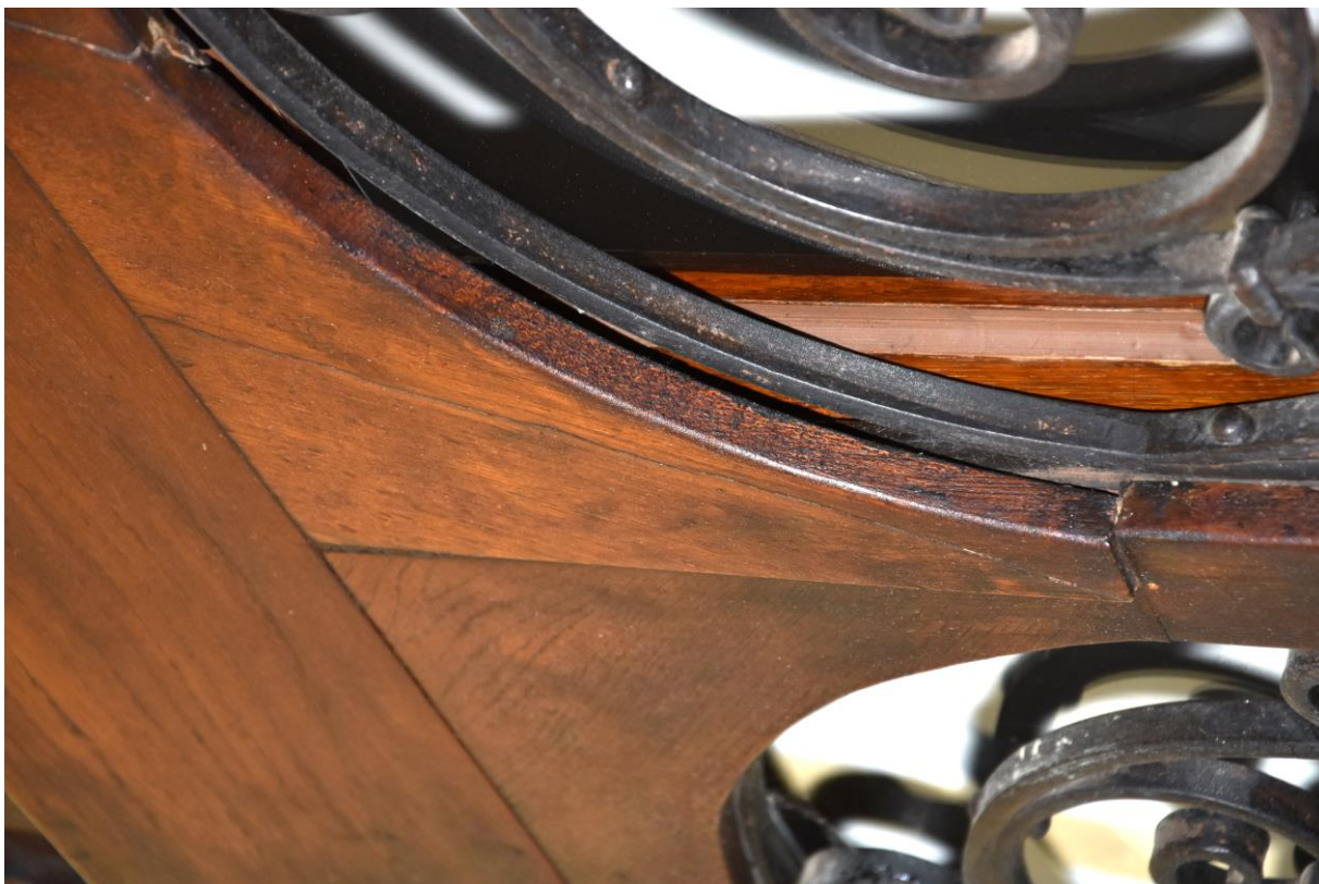
Dveře západního vstupu vnitřní, detail poškození lepené konstrukce, vnější plocha.
