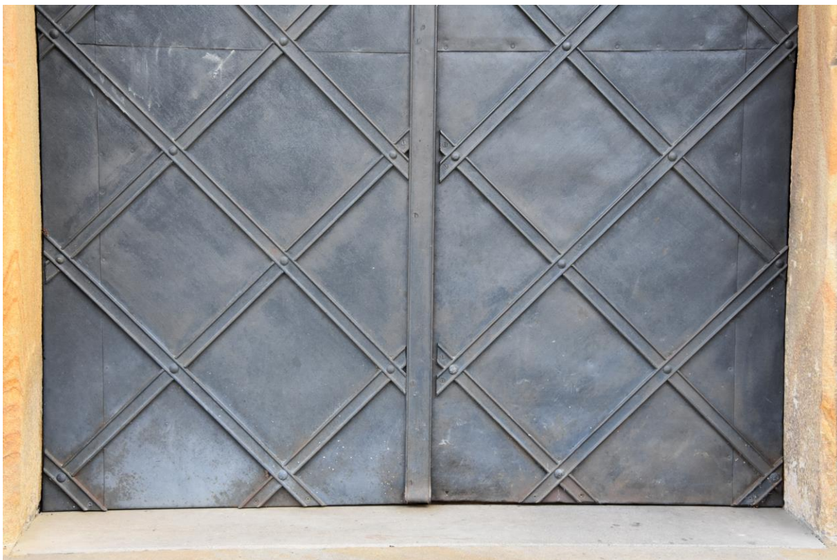
Vstupní dveře západního průčelí, detail vnějšího oplechování spodní části.
