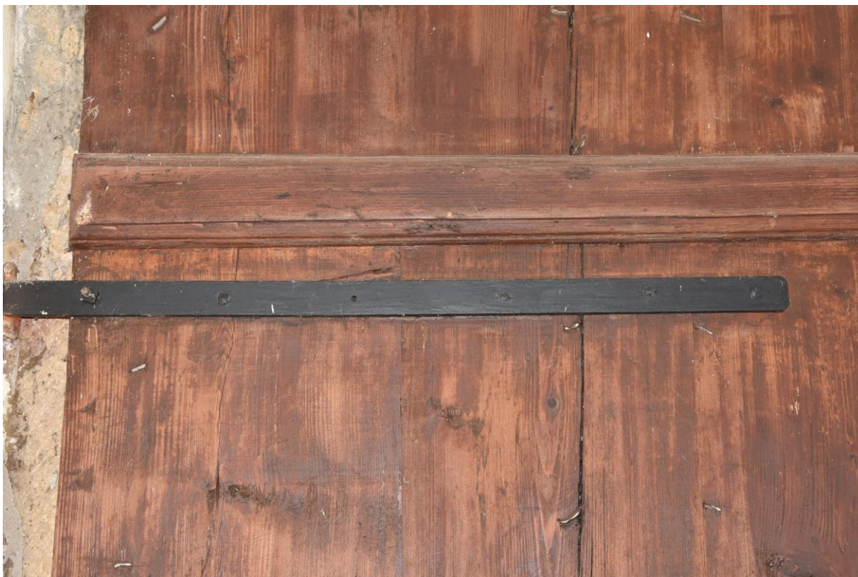
Dveře západního průčelí pravé, detail druhotného pásového závěsu, vnitřní plocha.
