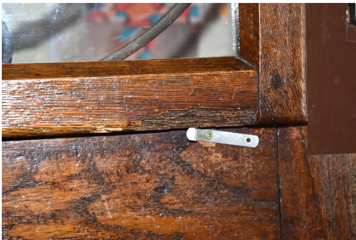
Dveře západního vstupu vnitřní, detail otevíracích okýnek s druhotným kováním.
