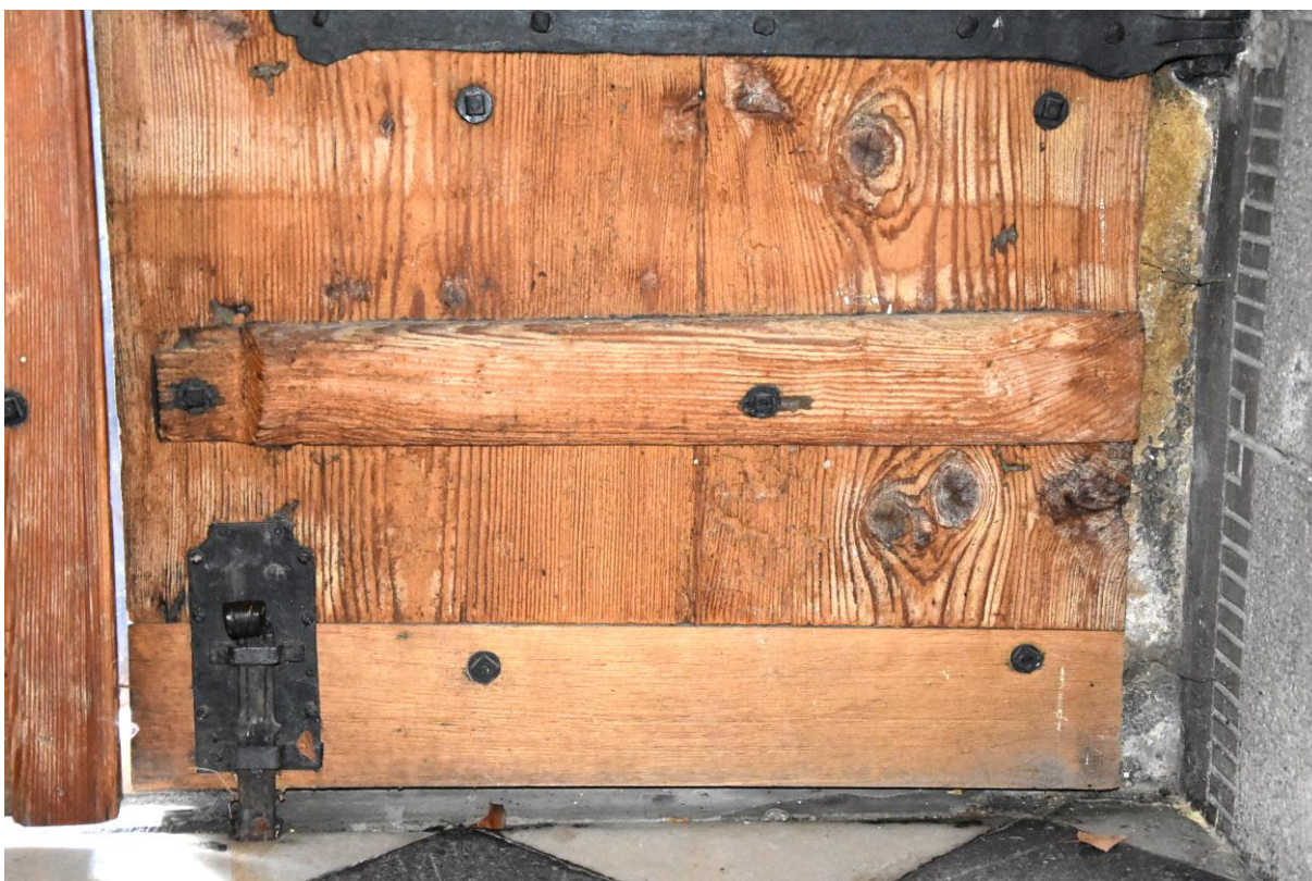
Vstupní dveře západního průčelí, detail spodní zástrčky na vnitřní ploše.
